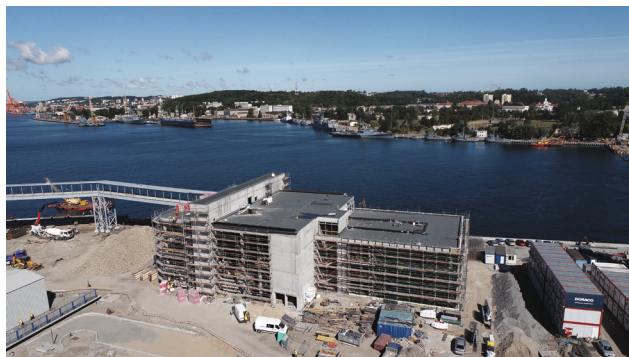
fol. zasoby Zarządu Morskiego Portu Gdynia S.A., budowa nowego terminalu promowego
